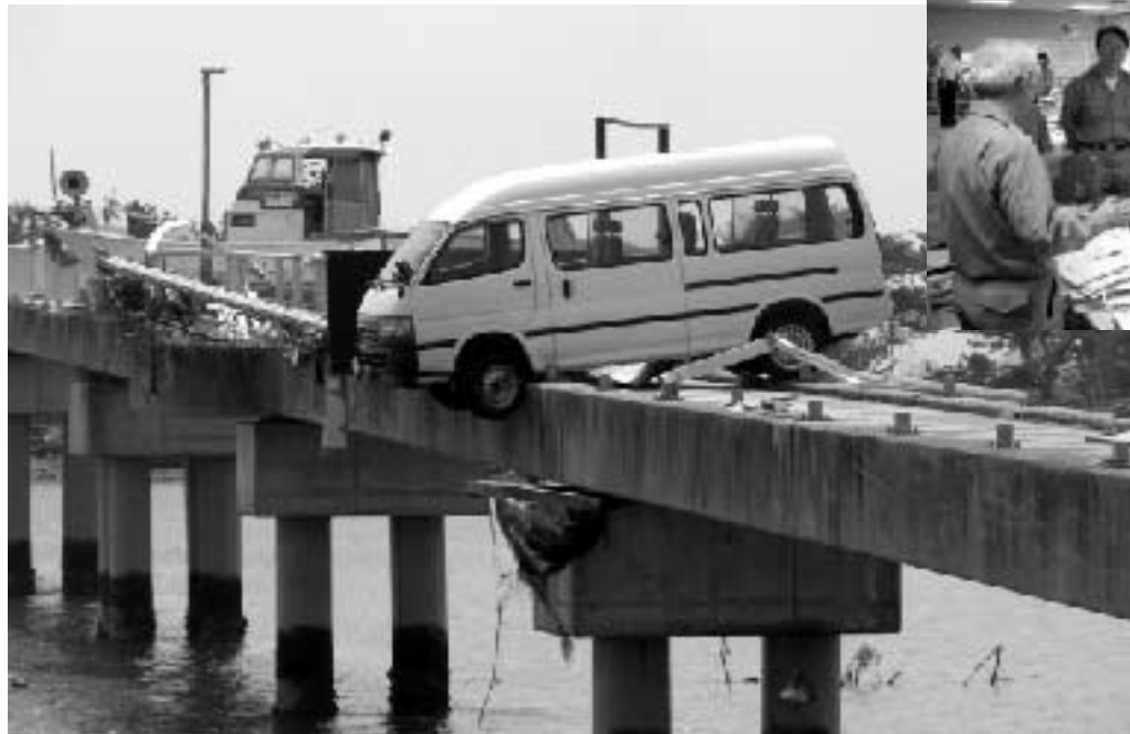
▼未だに津波で橋桁に乗り上げたままの車
