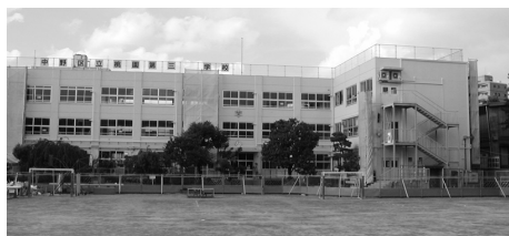
改修中の桃園第三小学校
