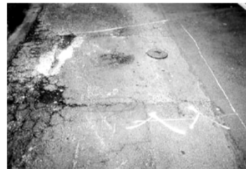
改修前 改修後
