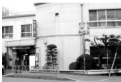
中野富士見町駅 エレベーター設置が可能な出入口右側の花壇
